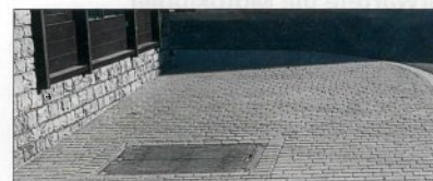
Die Pflasterung im Dorfzentrum Lenk.
